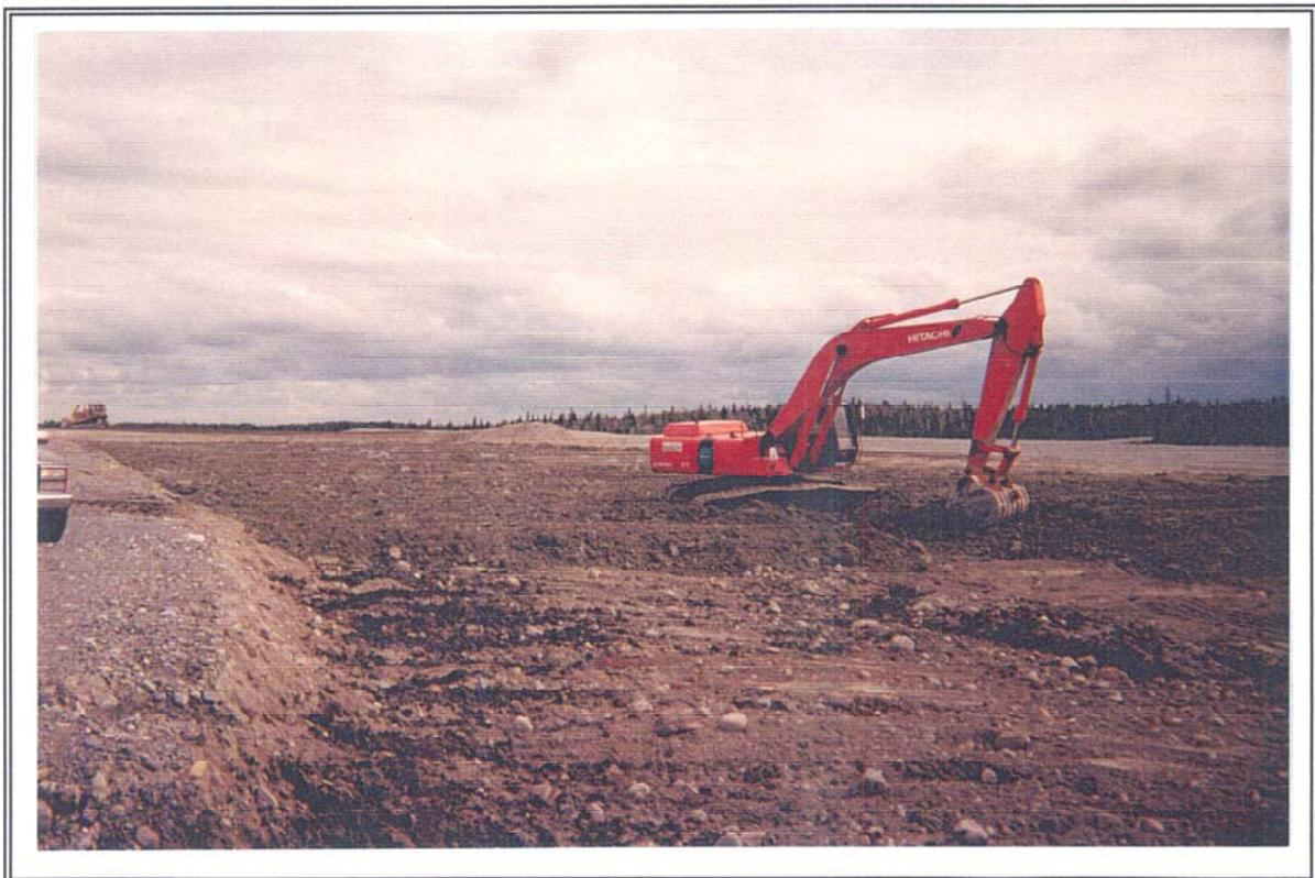
PHOTOGRAPHIE 35: Chemin d'accès. Mise en place de la Zone 2 (silt) sur la Zone 1 constituée du sable du chemin.
