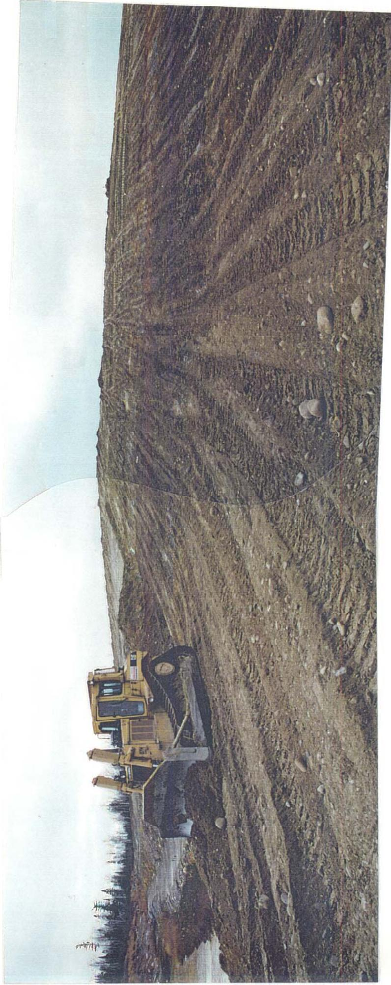
PHOTOGRAPHIE 11: Digue sud-est - nivellement de la pente.
