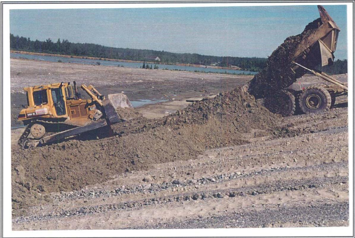
PHOTOGRAPHIE 32: Digue ouest. Mise en place de la Zone 2 (silt) sur la Zone 1 (sable).
