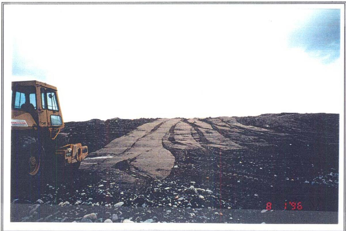
PHOTOGRAPHIE 31: Pente de la digue nord. Compactage de la Zone 3 (sable et gravier).
