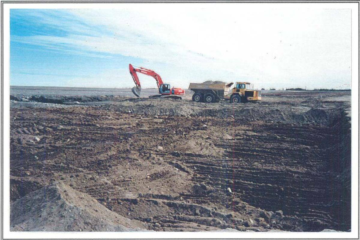
PHOTOGRAPHIE 36: Chemin d'accès sur le sommet du parc à résidus. Mise en place de la Zone 2 (silt).
