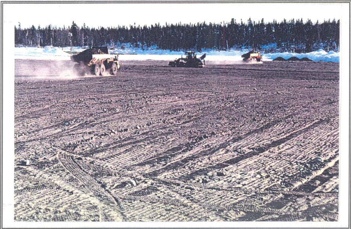
PHOTOGRAPHIE 2: Zone 1 (sable) mise en place, compactée et nivelée. Direction sud-est.
