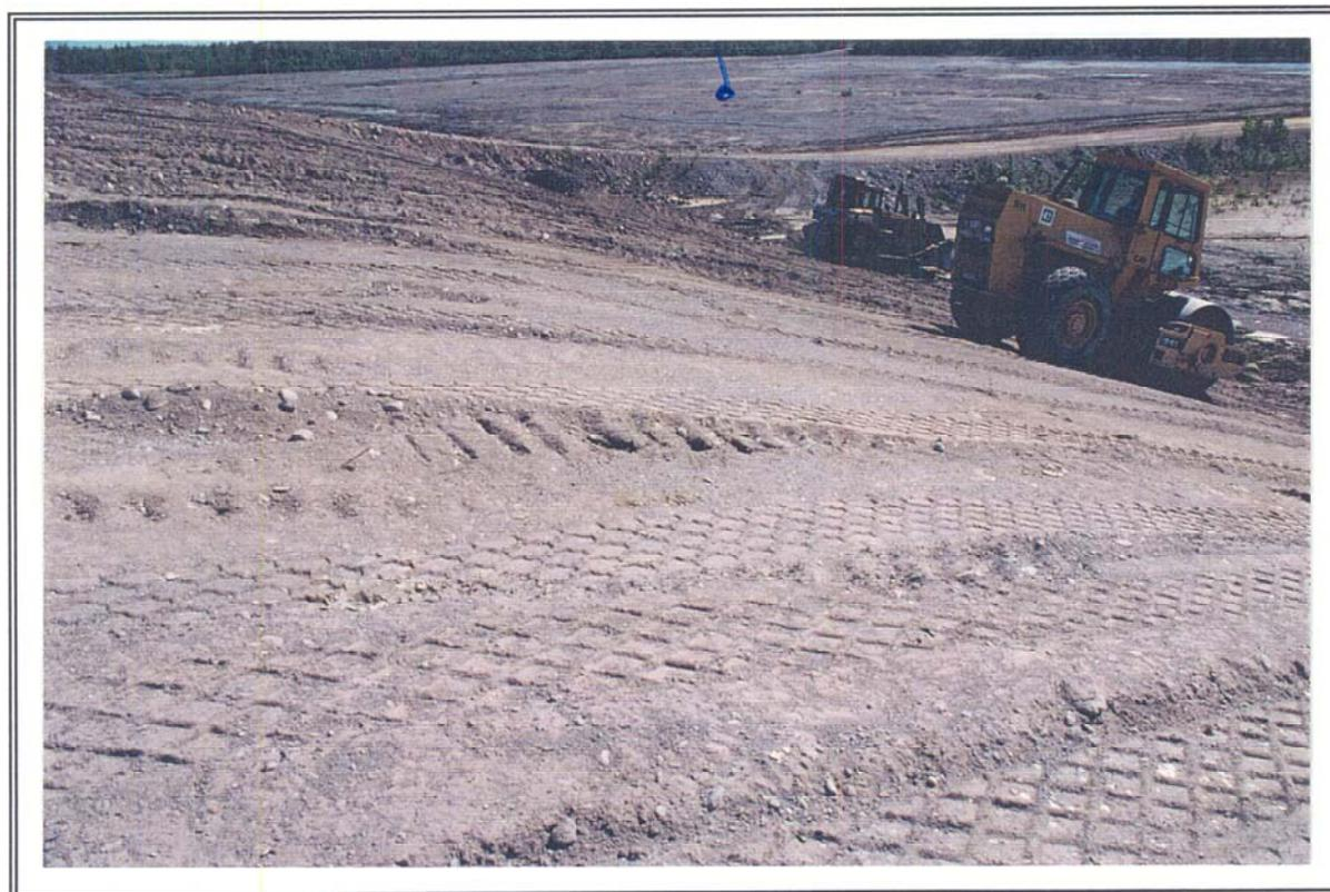
PHOTOGRAPHIE 26: Digue ouest. Mise en place et compactage de la Zone 1 (sable) de 0,5 m d'épaisseur.
