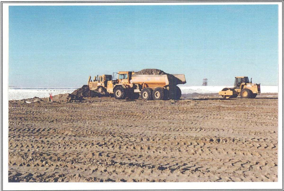
PHOTOGRAPHIE 18: Zone 1 - mise en place et compactage de la couche de sable et gravier.
