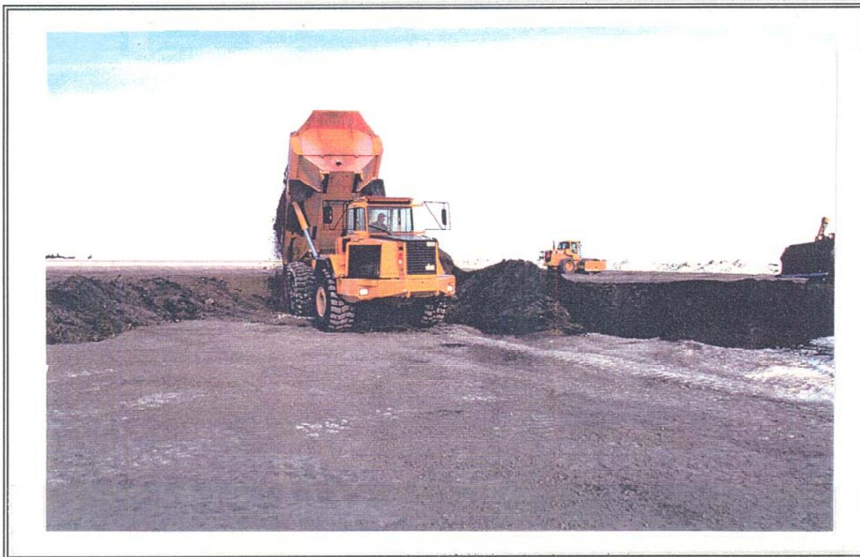
PHOTOGRAPHIE 20: Mise en place et compactage des résidus du MRN (Zone 2) sur la Zone 1 (sable).
