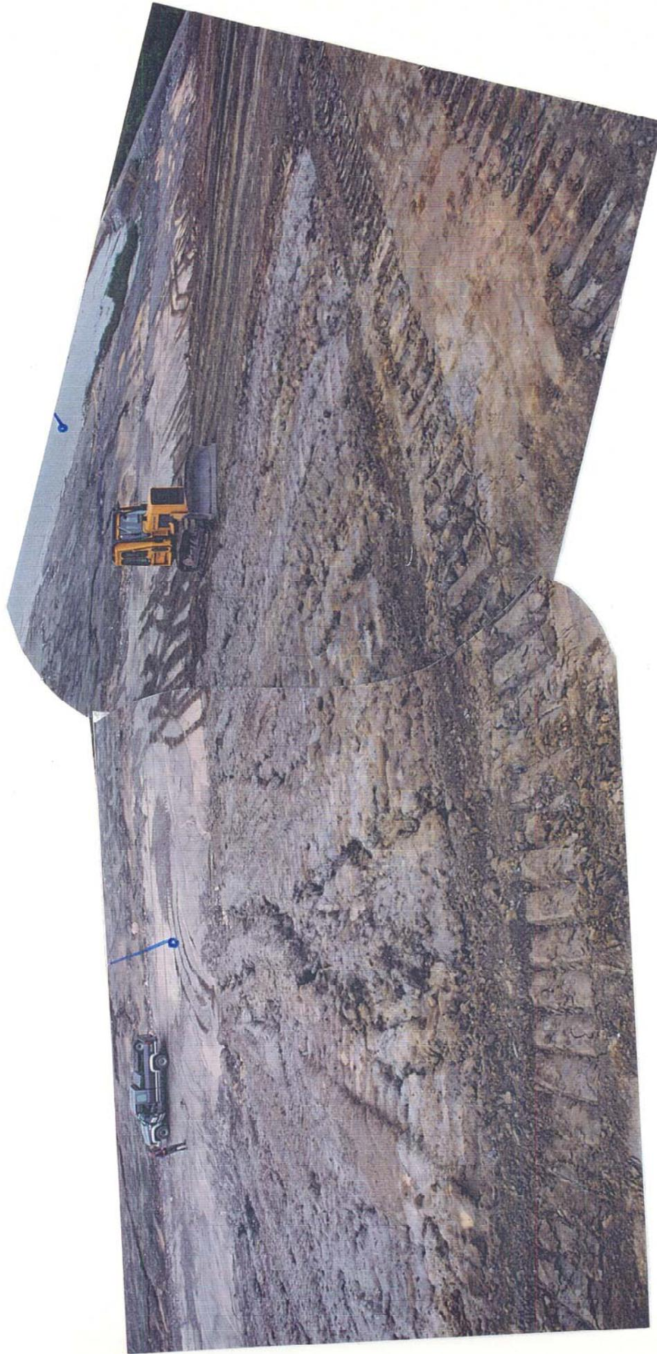
PHOTOGRAPHIE 24: Reprofilage de la digue ouest avant la mise en place de la Zone 1 (sable).
