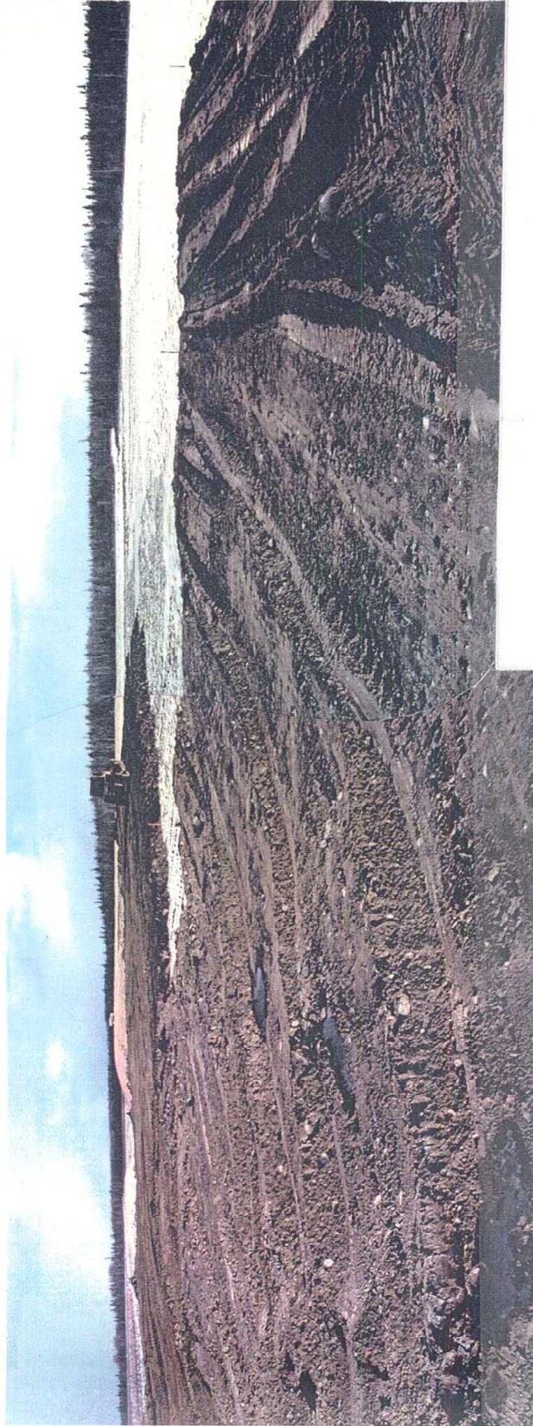
PHOTOGRAPHIE 1: Début des travaux. Mise en place de la Zone 1 (sable) de 0,5 m d'épaisseur. Direction sud-est.
