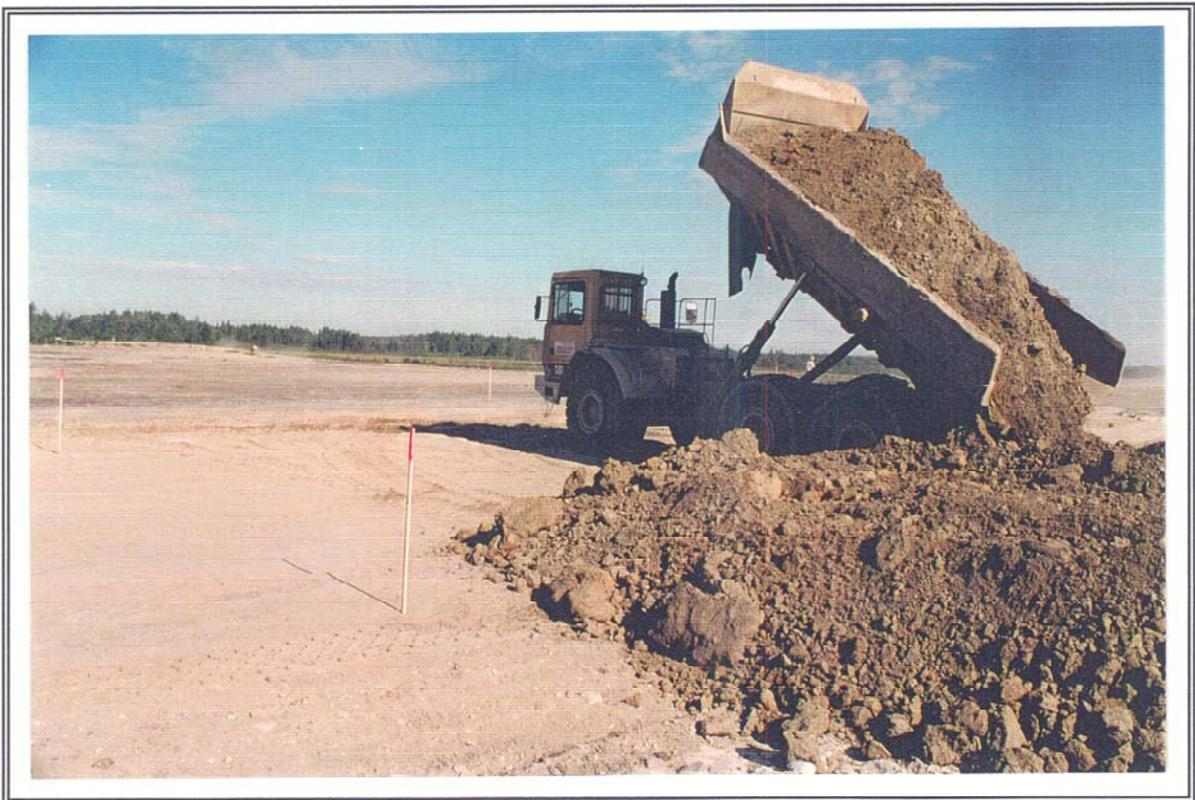
PHOTOGRAPHIE 33: Digue ouest. Mise en place de la Zone 2 (silt) sur la Zone 1 (sable).
