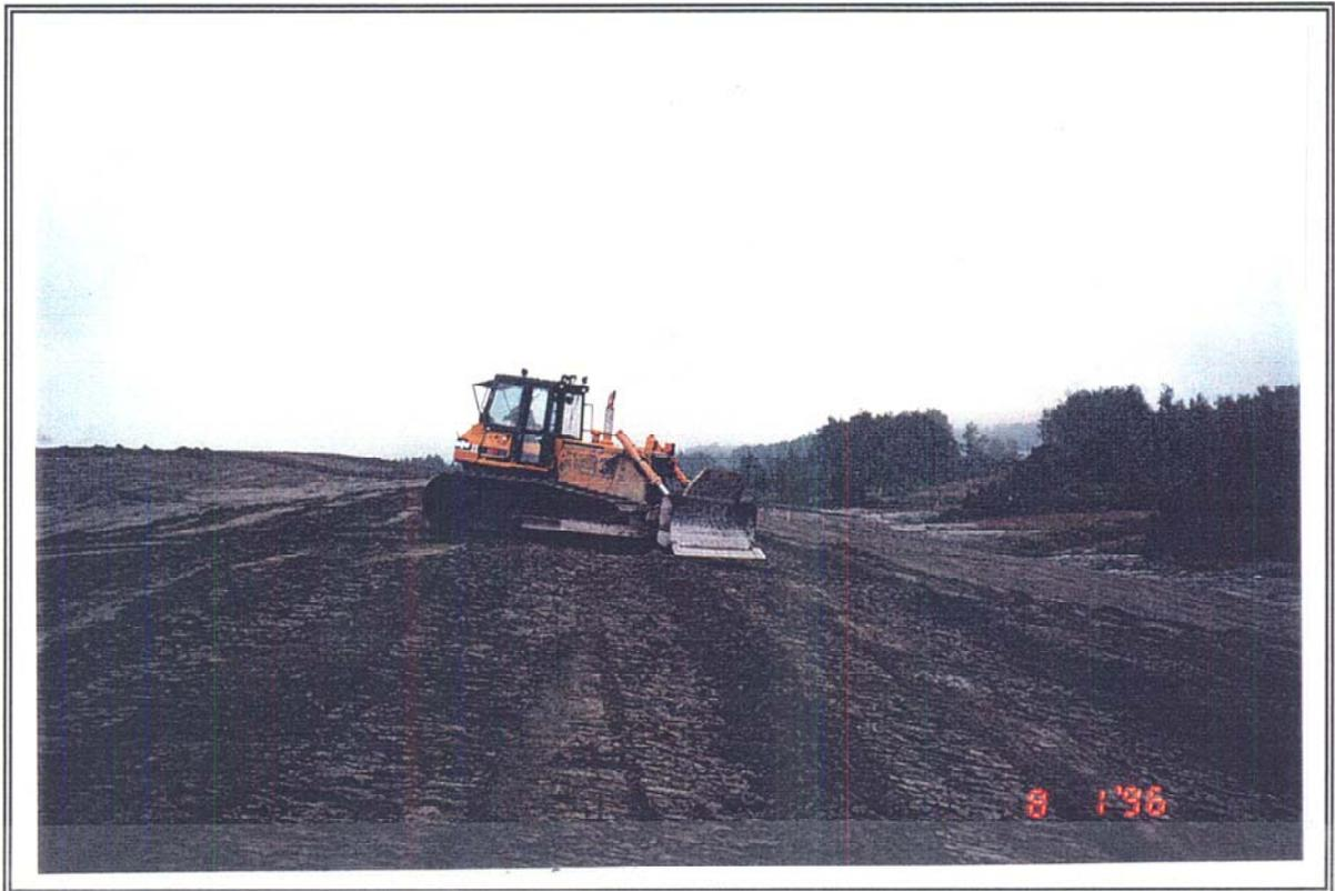
PHOTOGRAPHIE 30: Pente de la digue nord. Mise en place de la Zone 3 (sable et gravier).
