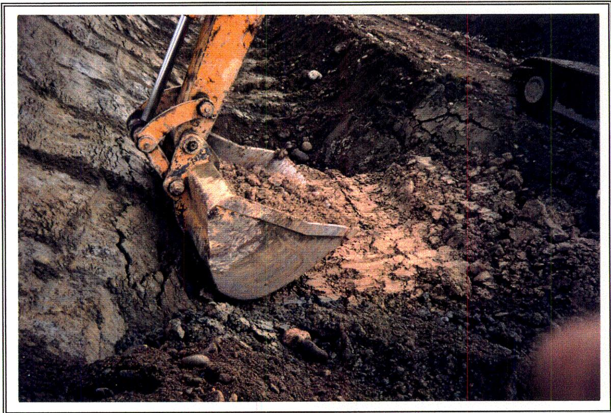
Figure 42: Mise en place du bris hydraulique (silt argileux)
